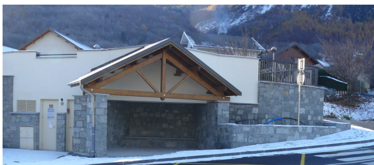
Finalisation de l'abri bus du Crosat
