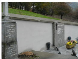
Réfection des murs du cimetière et aménagement du columbarium
